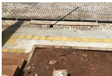
Figura 15 - Tipo de finalização entre concreto e bloco intertravado não será permitida
